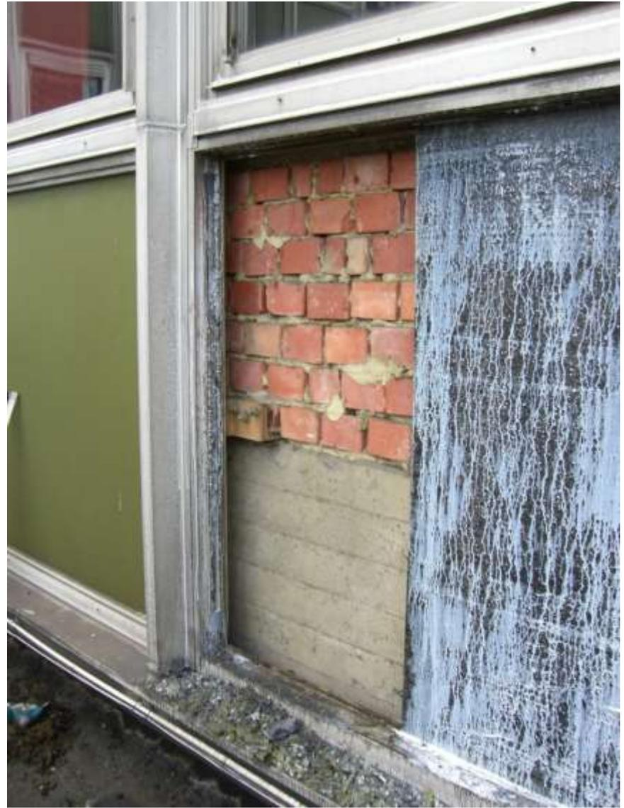
Sondages destructifs réalisés afin d'estimer l'impact du désamiantage sur le chantier et le budget. Présence de plaque de fibre-ciment liée attestée par le CSC de l'époque (1960).
